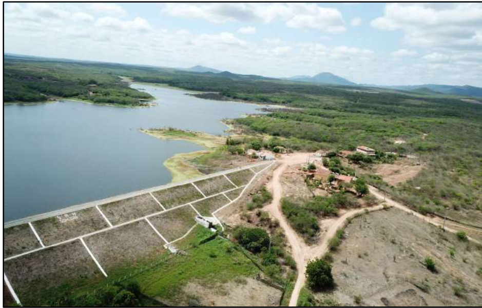
RH6 – BH Banabuiú – Barragem São José II – Piquet Carneiro/CE – Reservatório e Barragem
