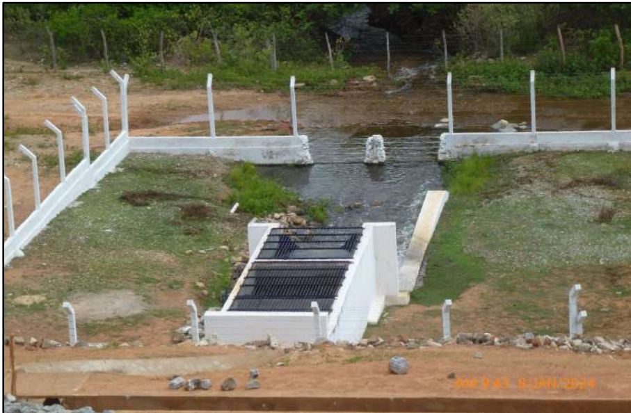
RH6 – BH Banabuiú – Barragem Cipoada – Saída do Descarregador de Fundo da Barragem
