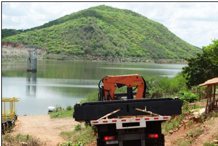
HR6 – BH Banabuiú – Açude Banabuiú – Recuperação da Comporta da TA/Descarregador de Fundo
