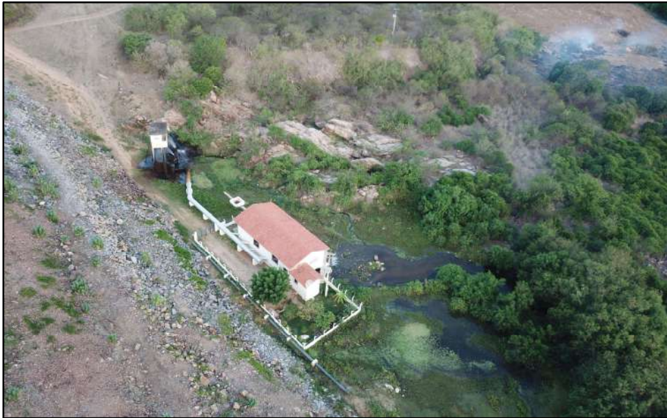
RH6 – BH Banabuiú – Açude Fogareiro – Casa de Operação do Descarregador de Fundo
