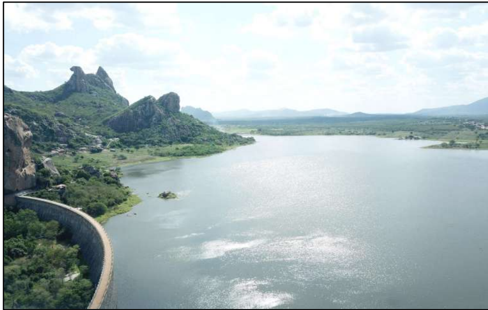
RH6 – BH Banabuiú – Açude do Cedro – Vista Geral do Reservatório
