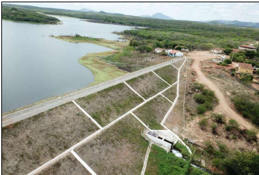
RH6 – BH Banabuiú – Barragem São José II – Descarregador de Fundo e Barragem de Solo
