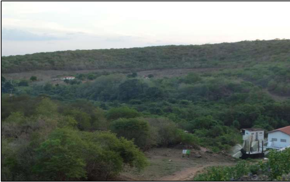
RH6 – BH Banabuiú – Açude Fogareiro – Ocupação da Área de Jusante
