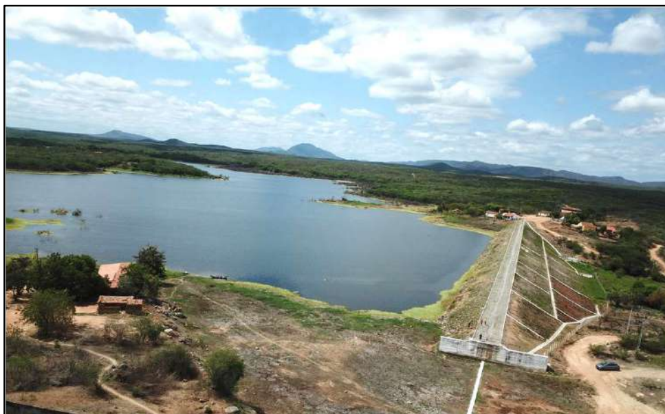
RH6 – BH Banabuiú – Barragem São José II – Piquet Carneiro/CE – Vista Geral da Barragem
