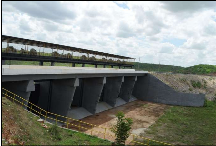
HR6 – BH Banabuiú – Açude Banabuiú – Sangradouro e Canal de Restituição
