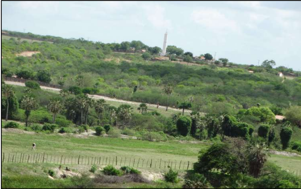
RH6 – BH Banabuiú – Barragem Cipoada – Ocupação da Área de Jusante da Barragem
