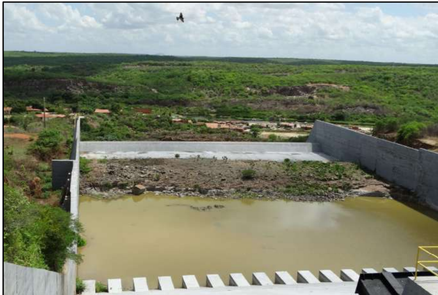
HR6 – BH Banabuiú – Açude Banabuiú – Bacia de Dissipação do Sangradouro
