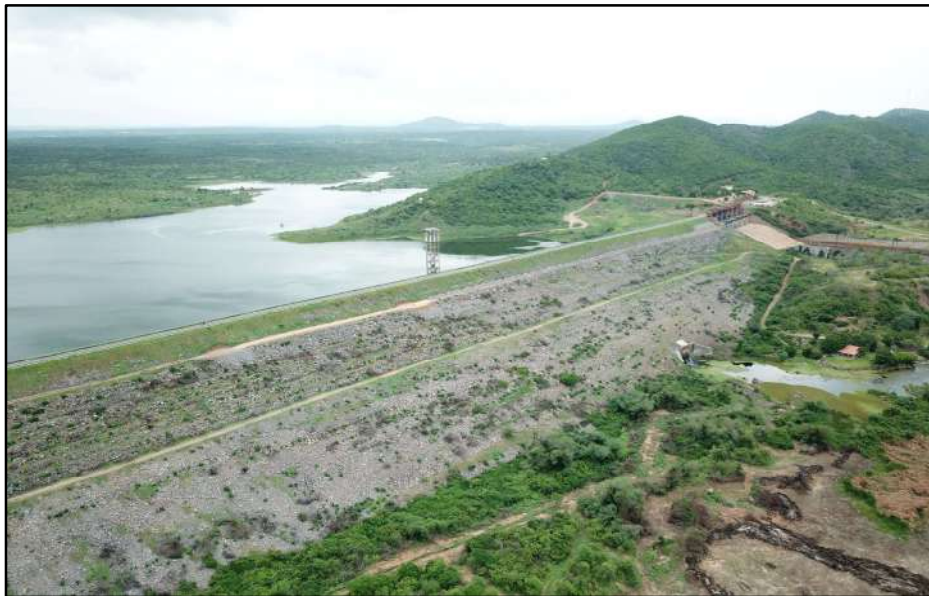
HR6 – BH Banabuiú – Açude Banabuiú – Visão Geral
