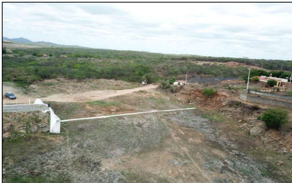
RH6 – BH Banabuiú – Barragem São José II – Sangradouro de Crista-Livre
