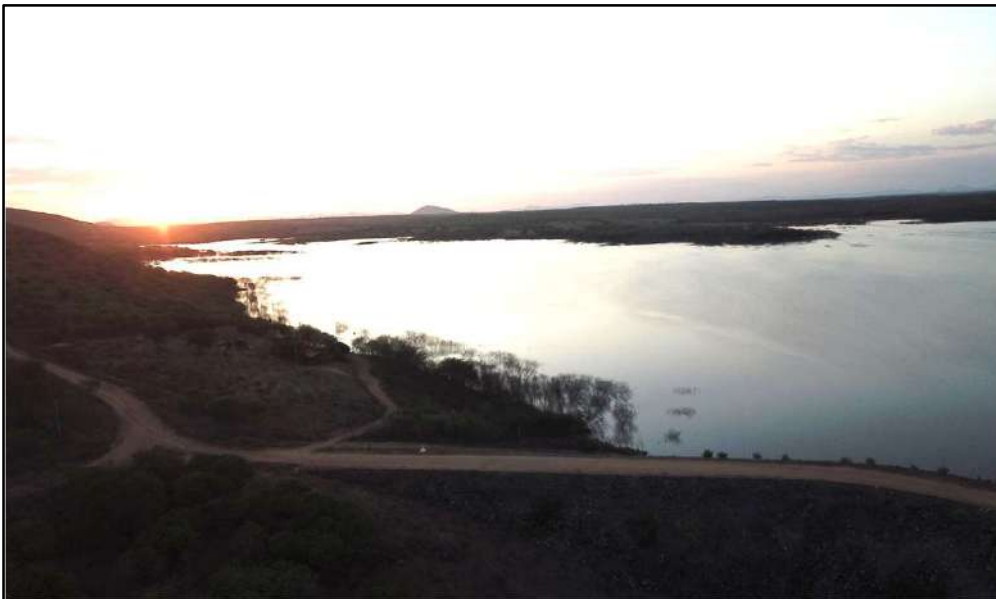
RH6 – BH Banabuiú – Açude Fogareiro – Vista Geral do Reservatório
