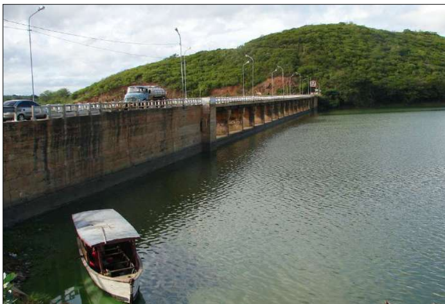
RH6 – BH Banabuiú – Açude Quixeramobim – Barragem e Sangradouro
