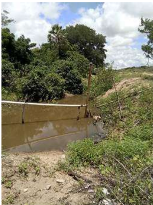
(h) Captação superficial
