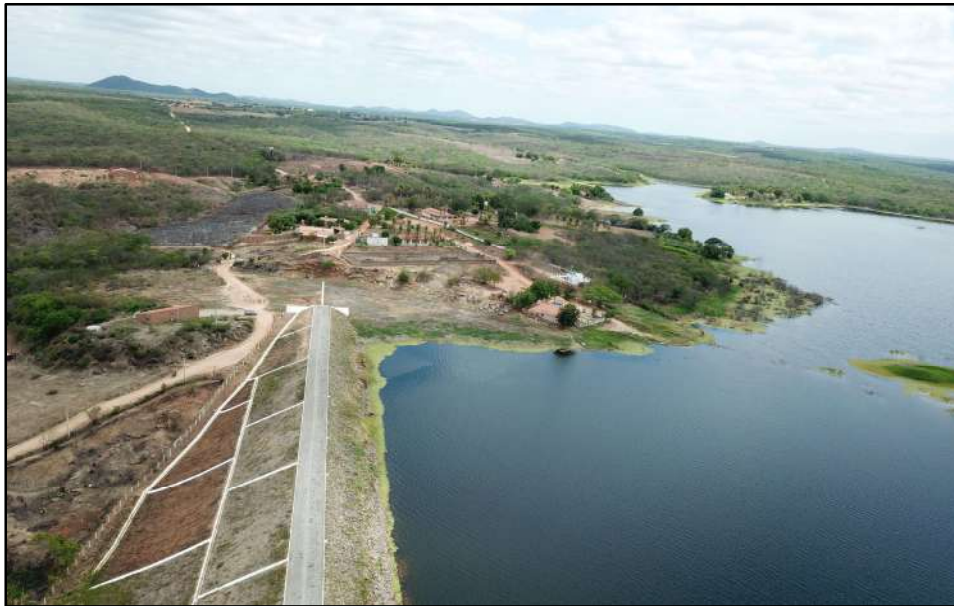
RH6 – BH Banabuiú – Barragem São José II – Reservatório e Barragem de Solo MD
