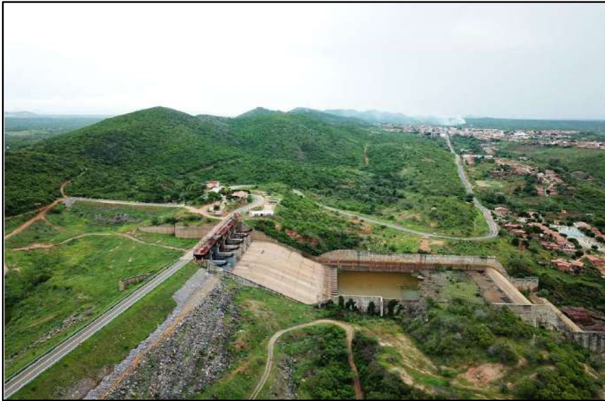
HR6 – BH Banabuiú – Açude Banabuiú – Barragem e Sangradouro
