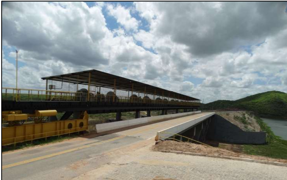
HR6 – BH Banabuiú – Açude Banabuiú – Sangradouro – Sistema de Acionamento
