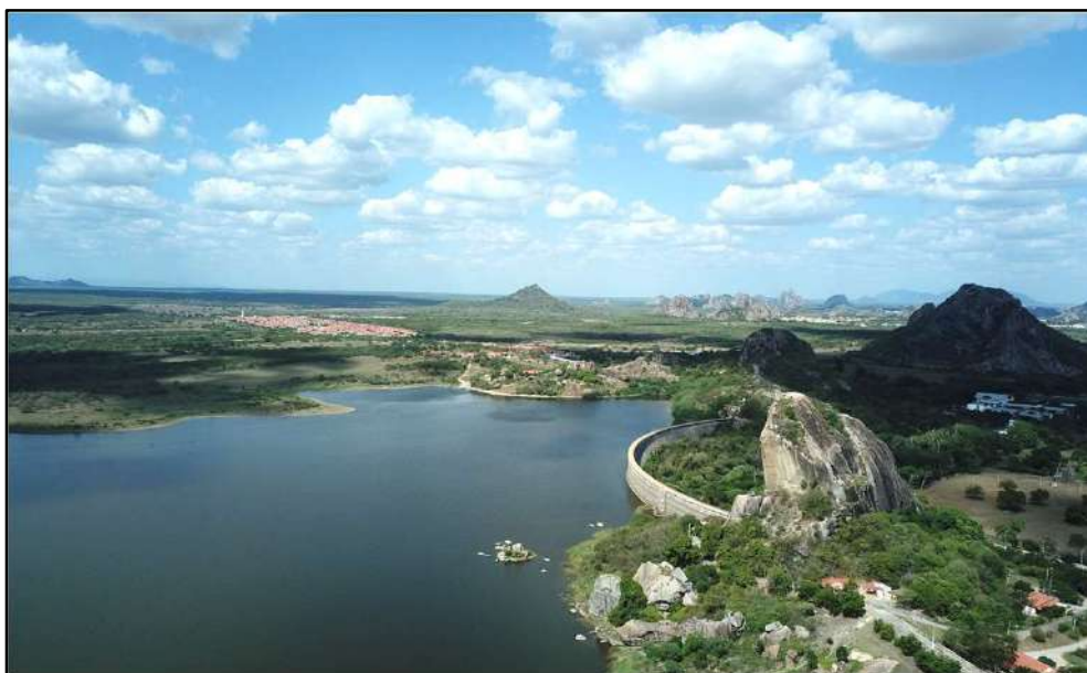
RH6 – BH Banabuiú – Açude Cedro – Vista Geral da Barragem
