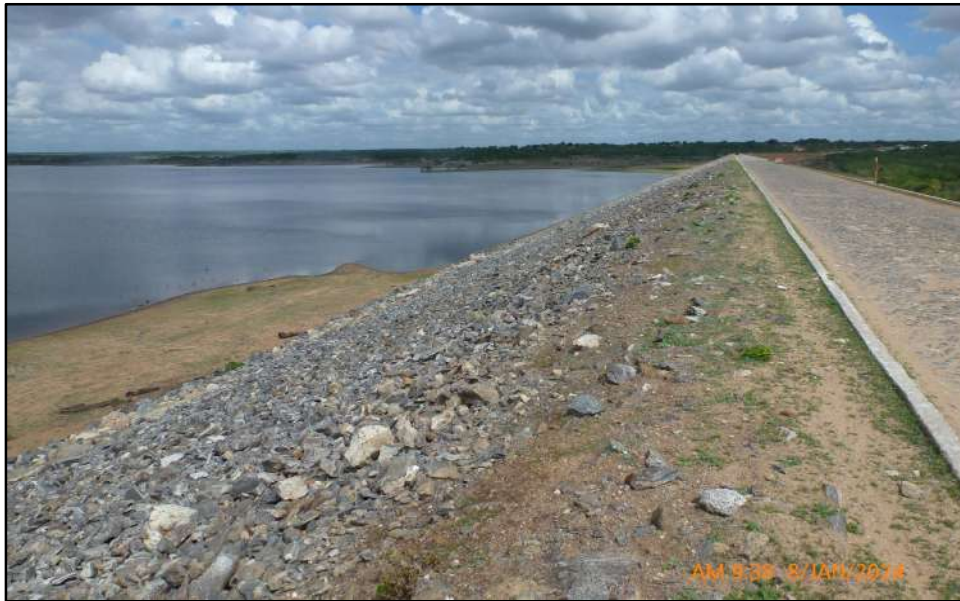
RH6 – BH Banabuiú – Barragem Cipoada – Talude de Jusante da Barragem
