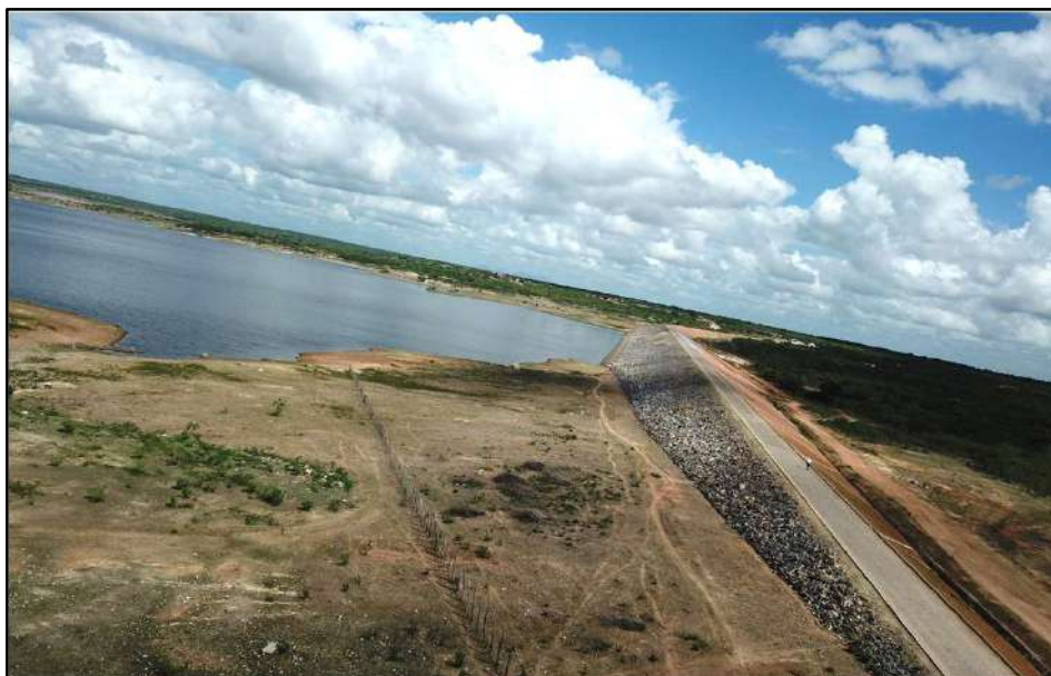
RH6 – BH Banabuiú – Barragem Cipoada – Vista Geral da Barragem
