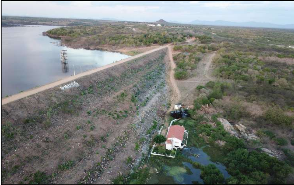
RH6 – BH Banabuiú – Açude Fogareiro – Barragem de Descarregador de Fundo
