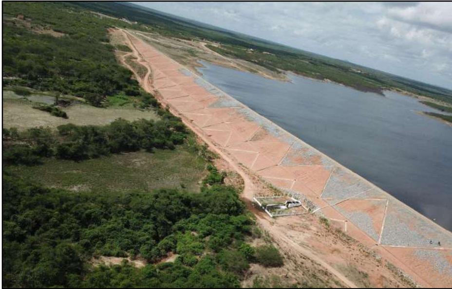
RH6 – BH Banabuiú – Barragem Cipoada – Vista de Jusante da Barragem
