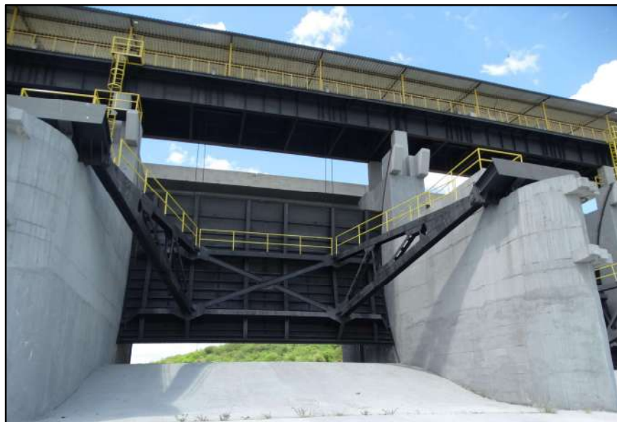
HR6 – BH Banabuiú – Açude Banabuiú – Recuperação das Comportas do Sangradouro
